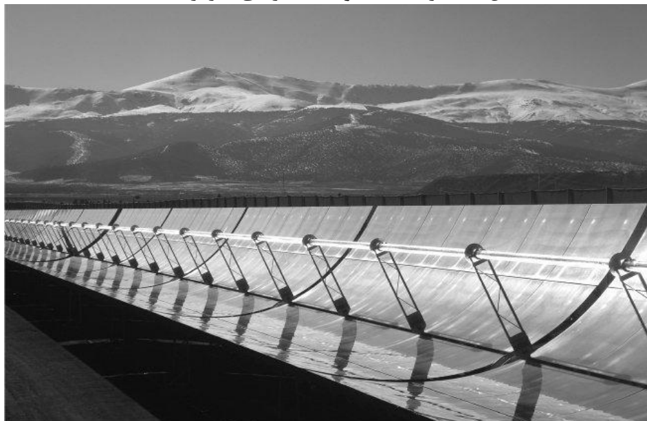
الف) آینده‌های سهموی: بخشی از نیروگاه آنداسول ۱، ۵۰ مگاوات، در اسپانیا
